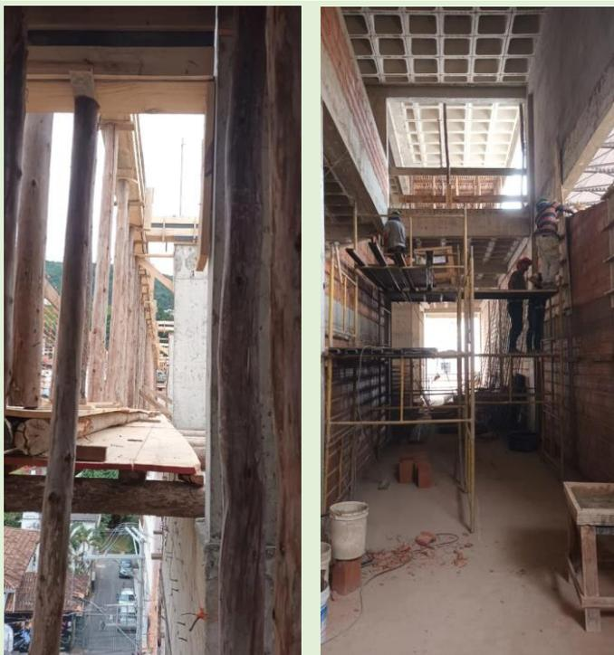
Nesta semana **12/05** a **16/05**, a obra seguiu com os ajustes finais dos painéis laterais das vigas, e a continuação do entijolamento e cintamento na área da 1ª rampa. Foi possível, também fazer o prolongamento da estrutura da laje na lateral esquerda.
