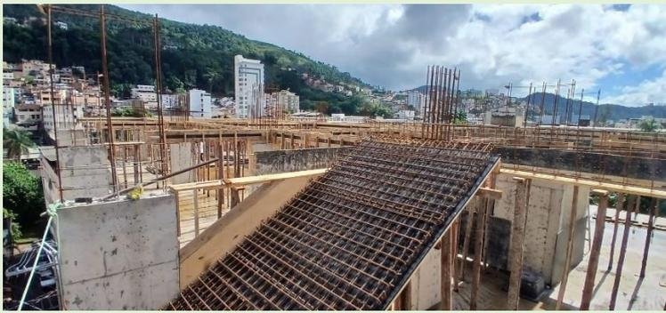
Nesta semana **05/05** a **09/05**, a obra seguiu com a conclusão da colocação dos painéis laterais das vigas, bem como, o entijolamento na área da 1ª rampa. Na próxima semana será colocado o forro da laje e a colocação das ferragens das vigas.
