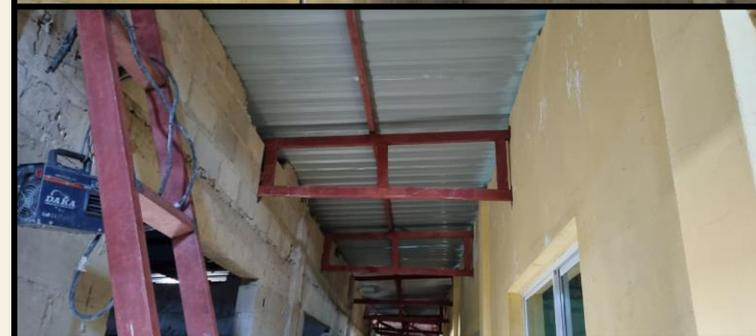
O Pastor Ngula comunica que o serviço de cobertura das quatro salas restantes, para completar o bloco das 12 salas, está concluído. As chapas/telhas de zinco foram colocadas sobre a estrutura metálica. Agora falta o reboco das paredes, instalação elétrica, piso e pintura.
