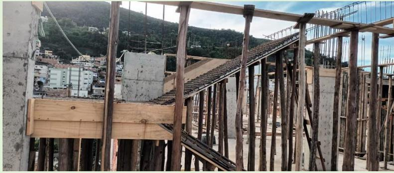
Nesta semana **22/04** a **25/04**, foi possível dar início a colocação dos fundos de viga para receber a ferragem e posteriormente o concreto. Os painéis retirados foram reformados. Foi possível, também, concluir a montagem de mais um lance de escada para atingir a 5ª laje, faltando apenas a colocação dos degraus.
