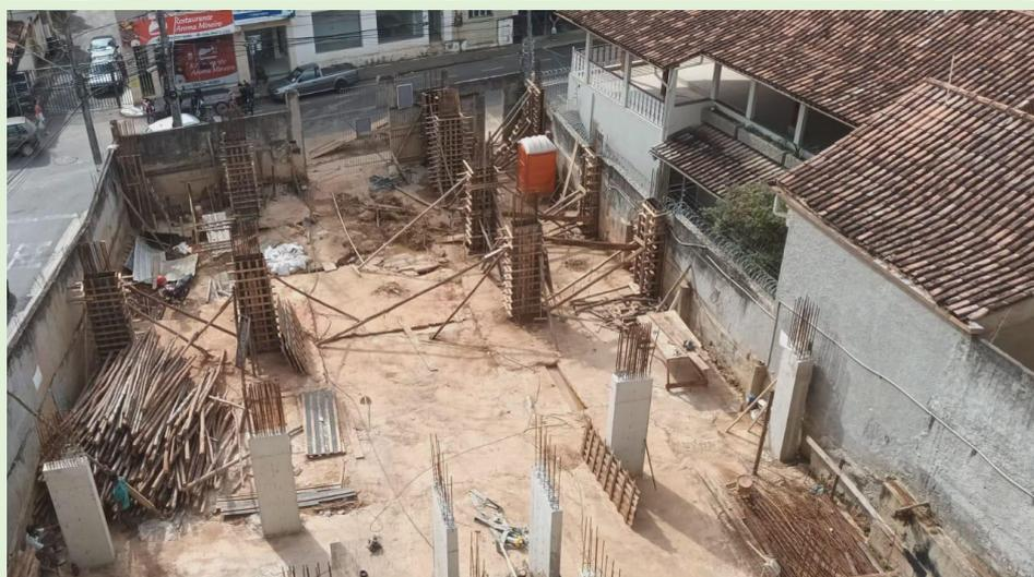
• Nesta semana (04/03 a 08/03) o trabalho seguiu na colocação de formas nas demais colunas, para concluir toda a concretagem das 30 colunas. Se Deus permitir em breve será montada a estrutura para bater a primeira laje.
