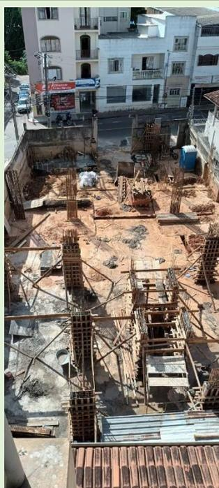
• Nesta semana (26/02 a 01/03) a obra deu um avanço considerável com o término da colocação dos painéis de madeira nas 19 colunas, bem como a concretagem das mesmas. A última sapata que precisava de um complemento de concreto foi preenchida. Na próxima semana vamos colocar painéis e fazer o enchimento de concreto das 11 colunas restantes.
